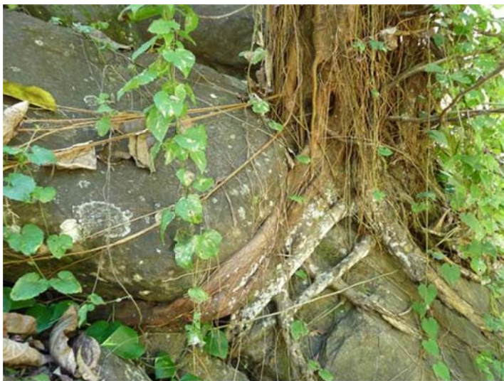
Photo : les racines viennent enlacer les enrochements
