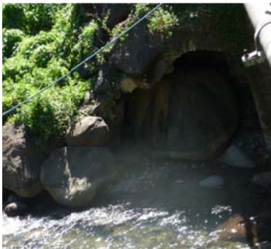
Photo : vu de l'enrochement bétonné qui se déstructure.
