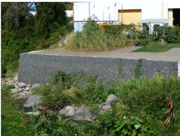
Photo : vu du remblai et du mur en gabions
