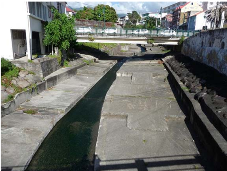
Photo : Vue du lit bétonné de la Rivière aux Herbes
