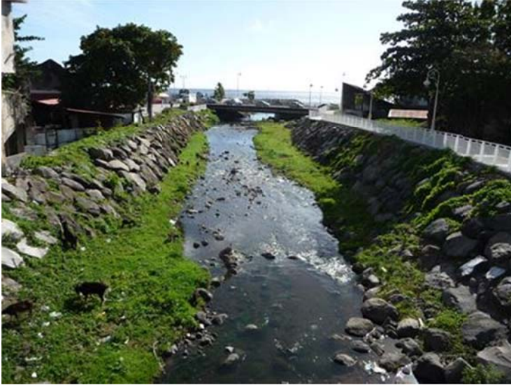
Photo : enrochements à l'aval de la rivière aux Herbes
