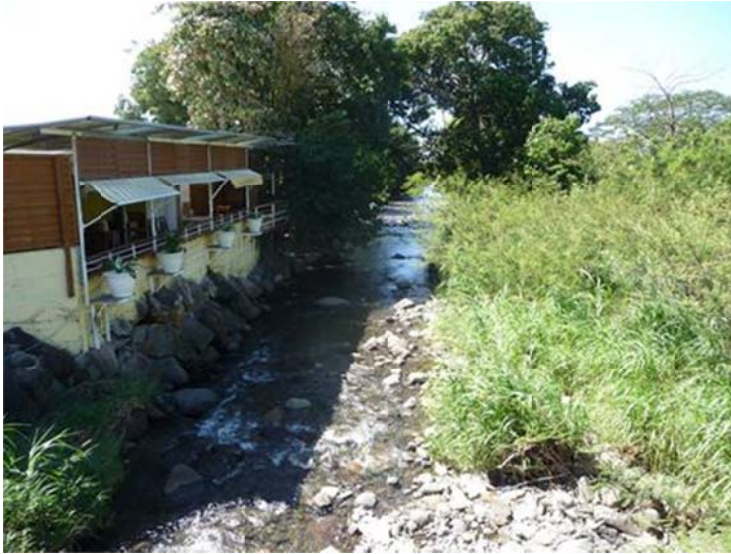
Photo : Enrochements bétonnés à l'aval de la rivière Losteau
