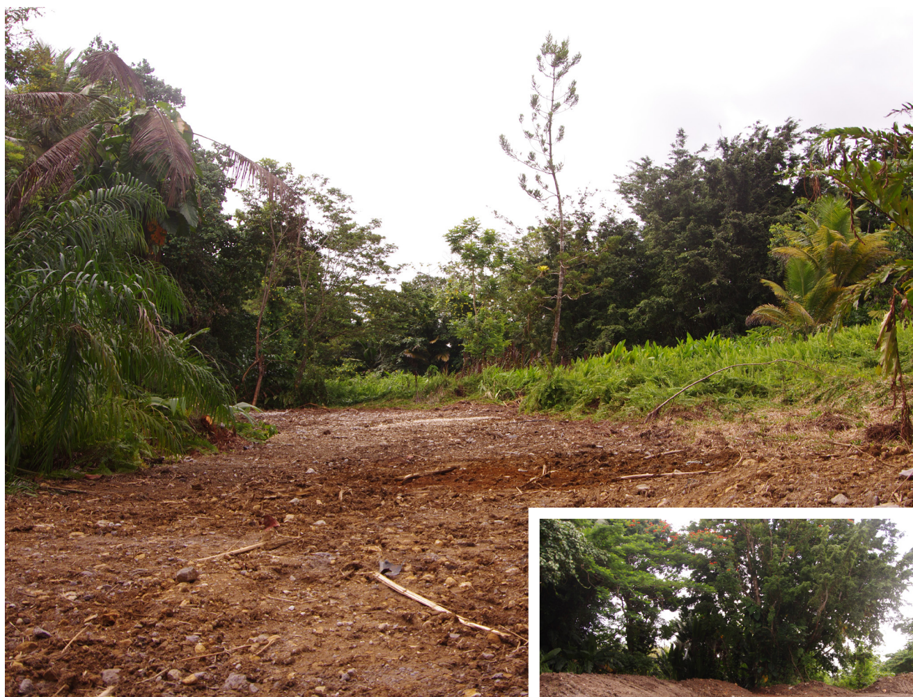
Travaux réalisés à Providence, G.Van-Laere/PNG
