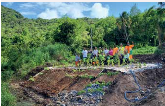
Fin du chantier-école de Gourbeyre dans le cadre du projet PROTEGER © PNG
