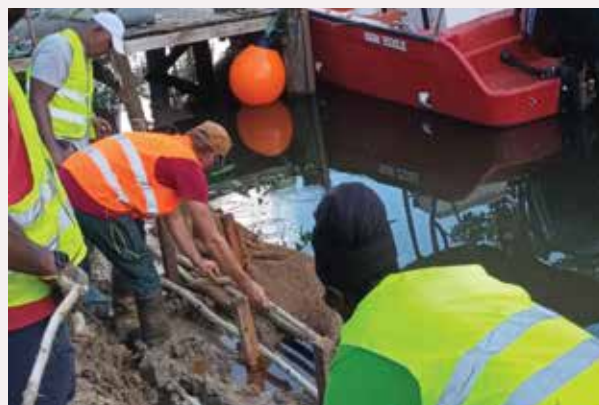
Chantier école de Morne-à-l'Eau dans le cadre du projet PROTEGER © PNG
