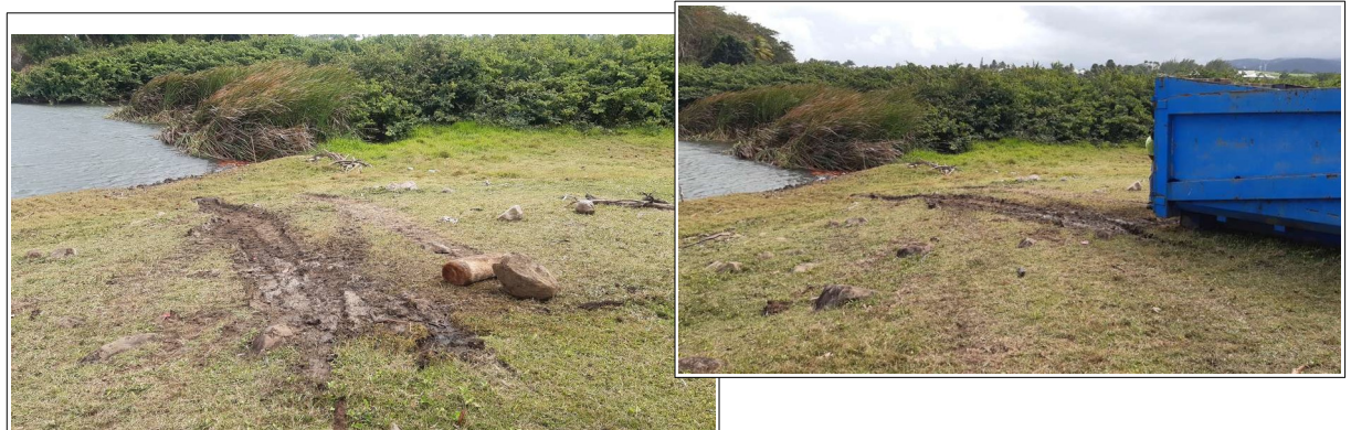
Figure 8: Impact du travail de la pelle sur le site, embouchure rivière
